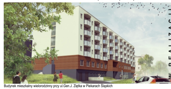
Budynek mieszkalny wielorodzinny przy ul. Gen. J. Ziętki w Piekarach Śląskich
