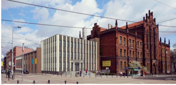
Termomodernizacja szkoły muzycznej w Bytomiu
