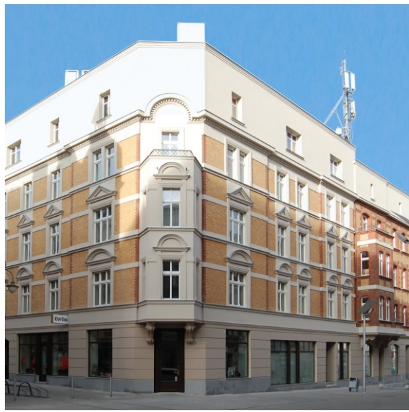
Remont kamienicy przy ul. Staromiejskiej w Katowicach
