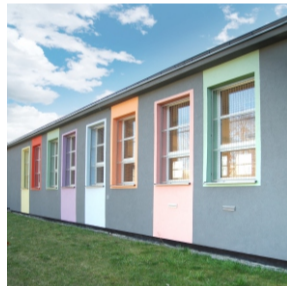
Termorenowacja sali gimnastycznej w Katowicach
