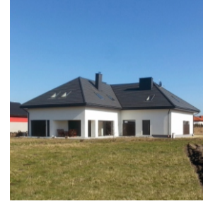
Budynek mieszkalny jednorodzinny w Katowicach
